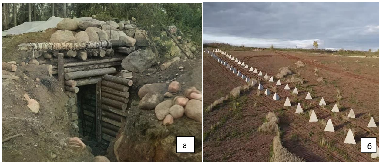
Рис.12. Фортификационные сооружения: а) блиндаж; б) заграждение типа «зуб дракона»
